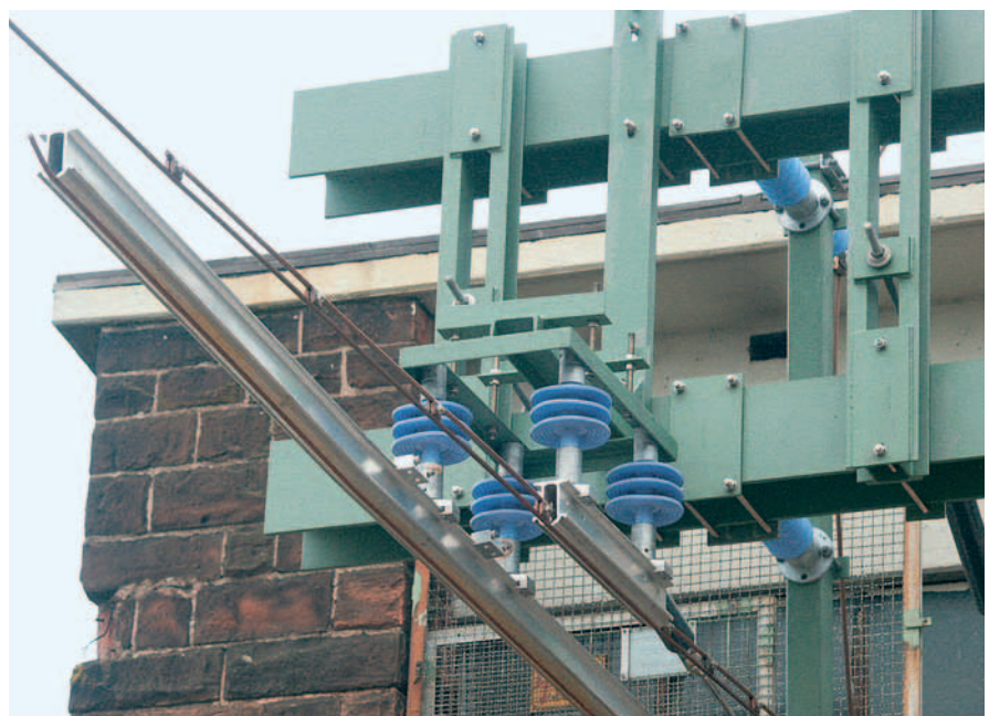
Bild 1: Einfahrt Wartungshalle Trier.
